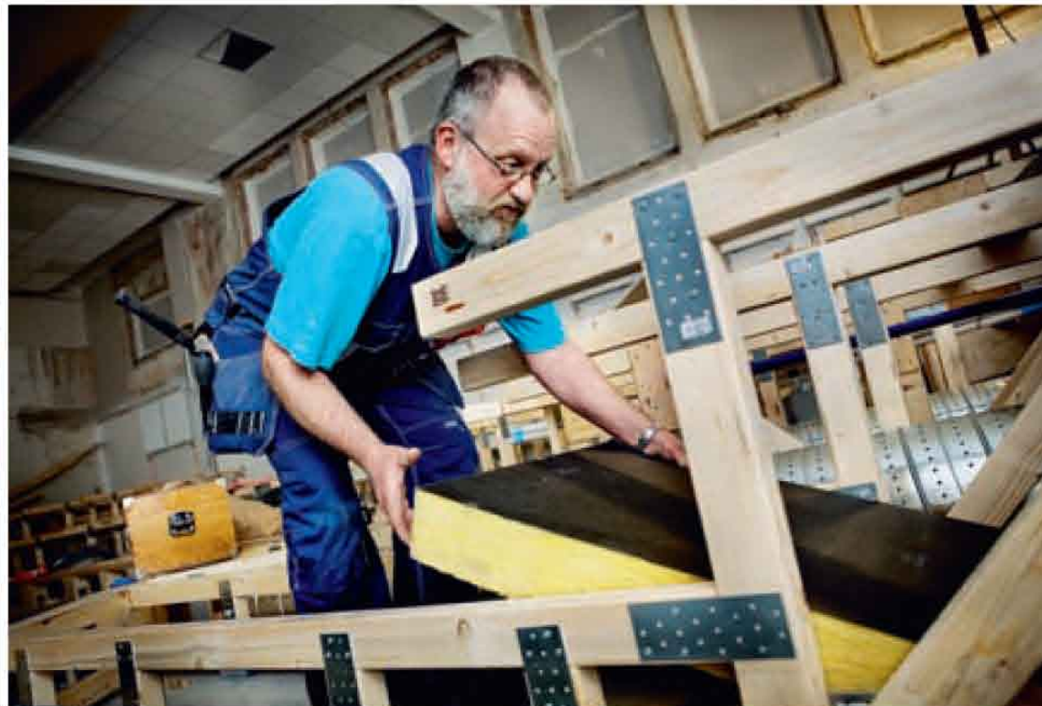
Hasse Carlzon lägger isoleringen på plats i trappavsatsen. Isoleringen är
