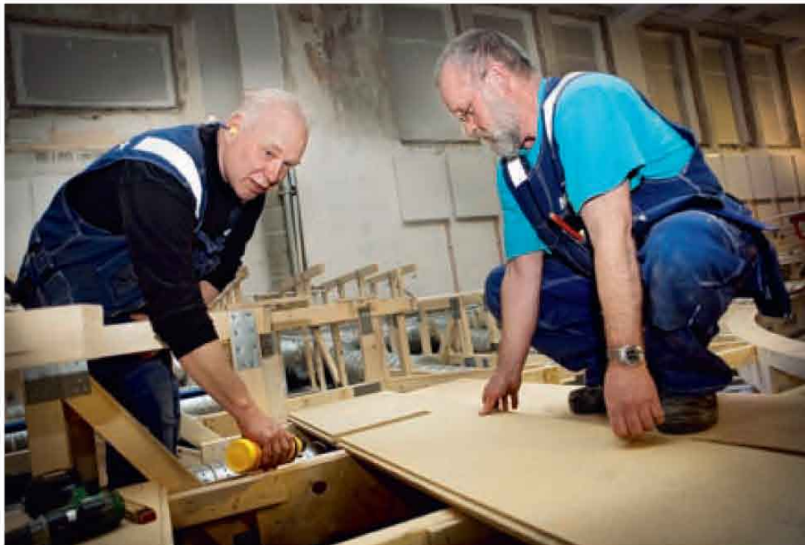
Snickarna Janne Söderlund och Hasse Carlzon bygger en trappavsats där operasångarna kommer att sitta. Allt limmas noggrant ihop för att det inte ska uppstå vibrationer och missljud. Regelstommen står på gummikuddar. Spånskivorna (2x38 mm) limmas ihop med dämplim.
