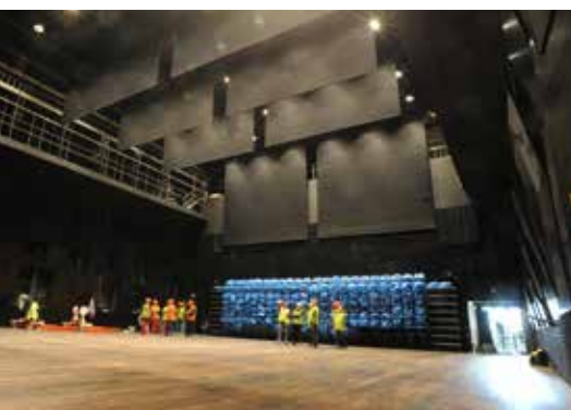
Ihopdragen teleskopplåtare och nedhissade akustikgardiner i Kuben.
