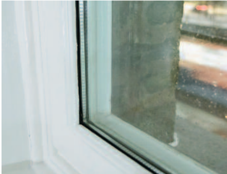
Vackra fönster från 1925 som byggts om med inre isolerruta för ljud- och värmeisolering. Detalj nedan.
