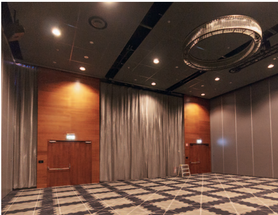
Figur 8: I taket ser vi öarna med mineralullsabsorbenter, och mellanrummet mellan dessa för AV-installationer. Mellan träpanelerna på väggarna sitter perforerade gipsskivor som är dolda bakom akustiskt transparenta metallnäsdraperier.
