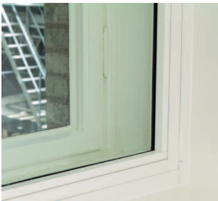
Fönster som försetts med inre båge och karm för att uppnå en hög ljudisolering mot innergården.
