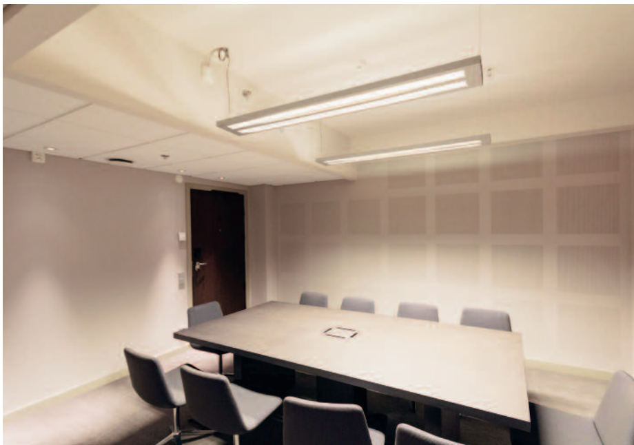
Figur 9: Stora delar av takytan är utan akustisk behandling, i flera av rummen med de gamla kassettaken bevarade. Ljudabsorptionen finns istället i perforerad gips på en eller två väggar, i heltäckningsmattan och i installationszonen med mineralullsskivor närmast dörren.
