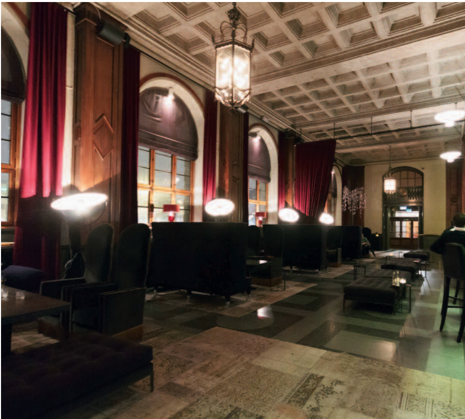
Kassahallens handristade betongkassettak och övriga ytskikt är orörda. Ljudabsorptionen kommer genom stor mängd tunga sammetsdraperier och höga stoppade stolar.
