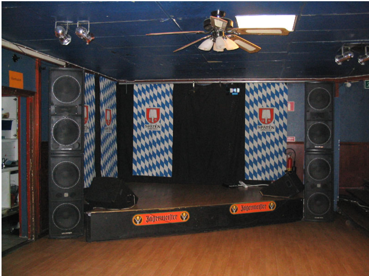
Bild 1. Scenen på Henriksbergs takterrass före ombyggnaden. Scenen är mycket liten och publiken hamnar mycket nära scenutrustningen och PA-högtalarna. Endast tunna textilier på scenväggarna och övermålade absorber i taket.
