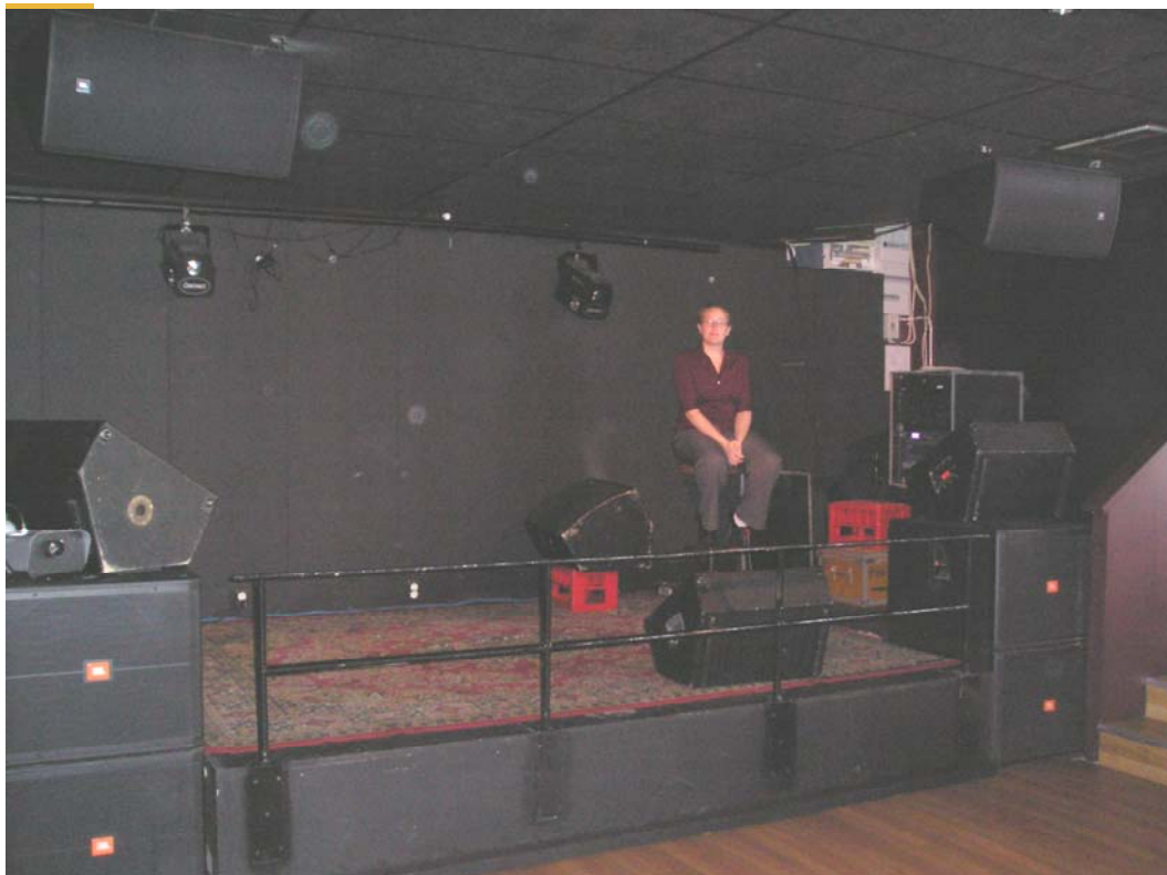
Bild 3. Bilden visar projektkoordinator Jenny Sandellsittandes på den nybyggda scenen. Två baslådor står infällda på var sida med upplyfta monitorer på. Det nya scengolvet byggdes upp på det gamla och gjordes mer resonansfritt än det tidigare. En matta på scengolvet bidrar ytterligare till dämpningen.
