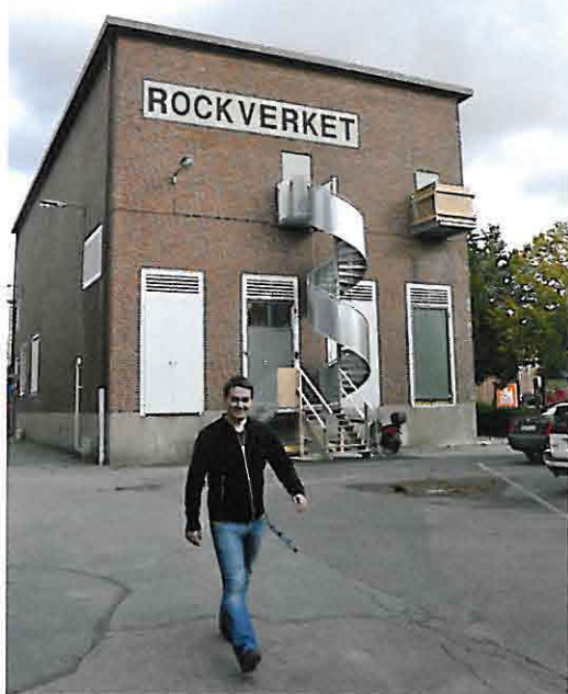
Markus Tagaris från ABF utanför det omvandlade ställverket.
