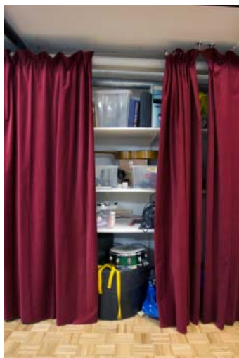
🔺 Tjockt tyg som fungerar som absorberent. Avståndet från väggen ut till tygets framsida är väl mätt för att absorbera givna problemfrekvenser. Tyget fungerar också som drapperi för avlastningshyllor bakom. Smart!
