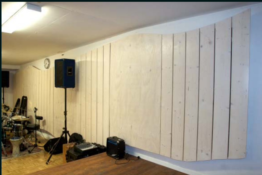
🔺 Hemb byggda basabsorbenter i form av membran- och spaltpanel i plywood. Absorbenterna är anpassade efter rummets resonansfrekvenser. Spännande är att beräkningarna har utgått ifrån 3d-modeller som har byggts i gratisprogrammet Sketchup från Google.
