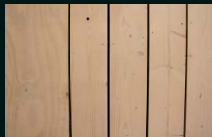
🔺 Hemb byggda basabsorbenter i form av membran- och spaltpanel i plywood. Absorbenterna är anpassade efter rummets resonansfrekvenser. Spännande är att beräkningarna har utgått ifrån 3d-modeller som har byggts i gratisprogrammet Sketchup från Google.
